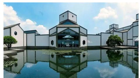
光。苏博的玻璃屋顶与石屋面相互映衬，不仅在视觉造型上令人赏心悦目，而且在使用功能上也匠心独运，使得自然光线透过木贴面的金属遮光条交织成的光影，进入到博物馆的活动区域和展区。光线经过色调柔和的遮光条的调节和过滤所产生的层次变化，以及不同空间光线的明暗对比，仿佛能让周围的线条流动起来，令人入诗入画，妙不可言。
